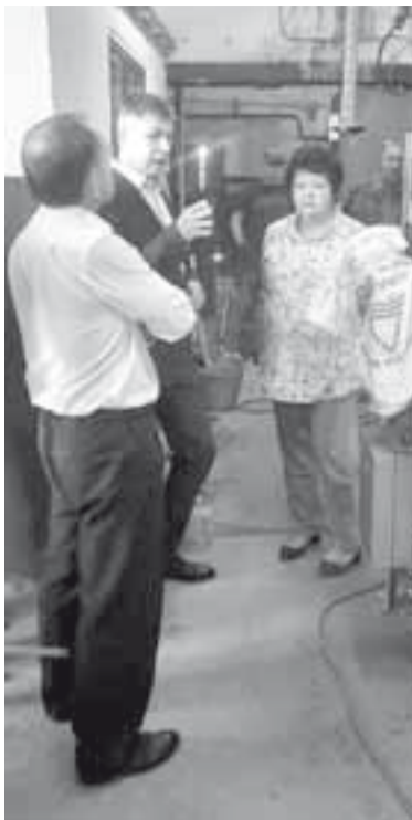
Ремонт котельной, которая отапливает 907 квартал г. Орла, уже вызывает тревогу по срокам и своевременному запуску
