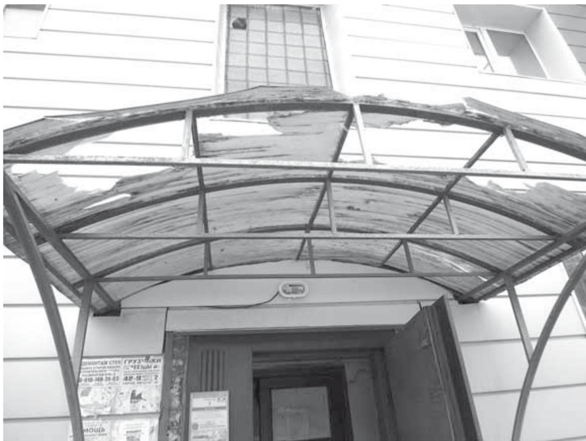
В ноябре 2006 года по материалам обследования несущих конструкций жилого дома № 28 на ул. Шаумяна ЗАО «Орелгипроприбор» подготовило технический отчет с выдочкой заключения: техническое состояние фундаментов, наружных и внутренних несущих стен, козырьков над входами в подъезды признано неудовлетворительным.
